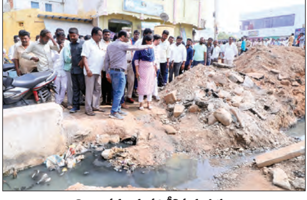
నిర్మాణ పనులను పరిశీలిస్తున్న డ్య.శంకర్
